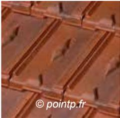
Tuiles mécanique : plate à emboîtement
