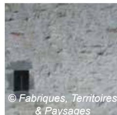
Enduit couvrant réalisé au mortier de chaux
